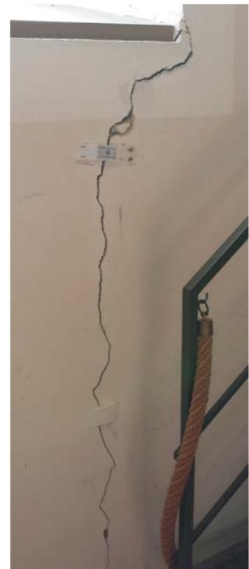
*Im Inneren wird die Rissbildung noch deutlicher. Sie ist mit Markierungen gekennzeichnet.*
